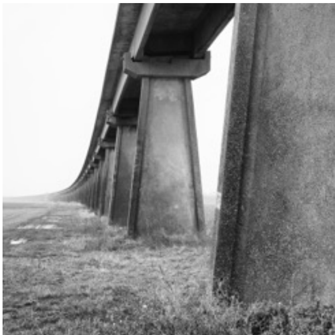
VIADUC DE L'AÉROTRAIN DE JEAN BERTIN, PILIER 778
